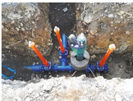
Wasserleitungen und -schieber
