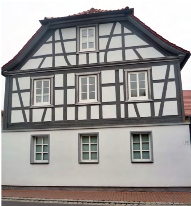
Harmonische Anordnung der Fenster in der Fassade
