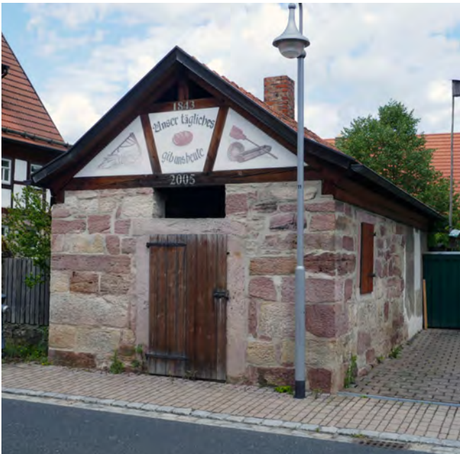
Fassadenmalerei im Fachwerkgiebel (Backhaus)
