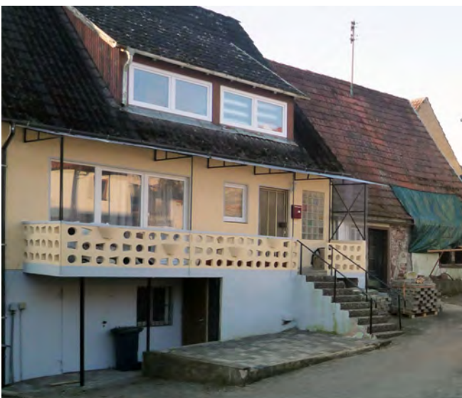
Negativbeispiel: unpassende Balkonbrüstung und Kunststoffüberdachung
