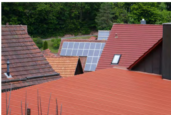
Typisches Farbspektrum der Eindeckungen: rot - rotbraun - braun Fränkischer Rinnenziegel
