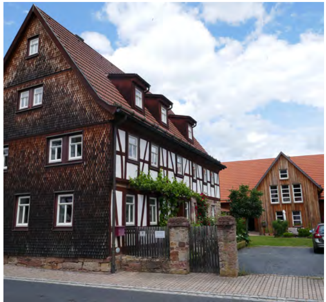
Eingangsbereich: Mauersockel mit Holzzaun, Mauerpfeiler und Pforte
