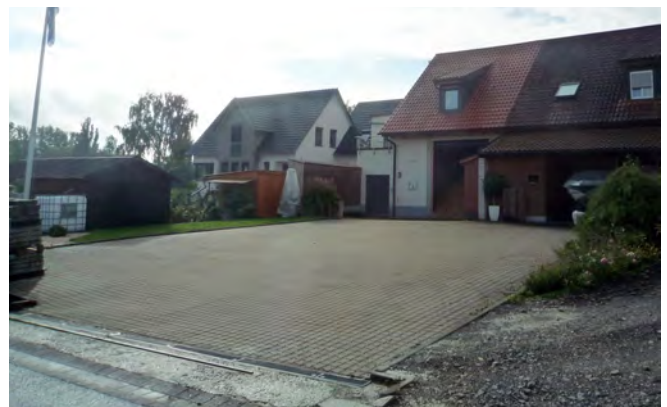
Negativbeispiel: vollständig versiegelter Hofbereich
