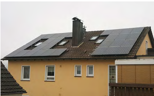
Negativbeispiel: unregelmäßig angeordnete Module
