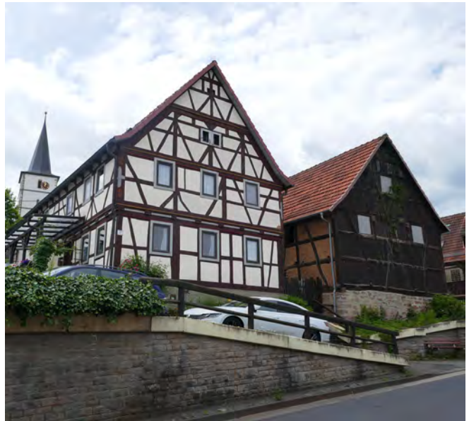
Fachwerk mit Putz (Wohngebäude) und Holz (Scheune)
