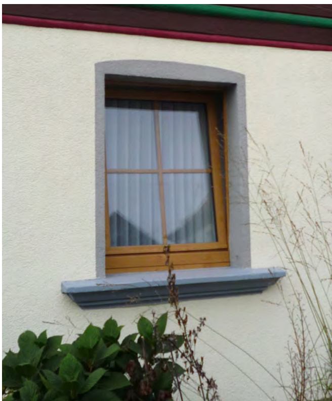
Fenster mit Putzfaschen und Fensterbank aus Naturstein
