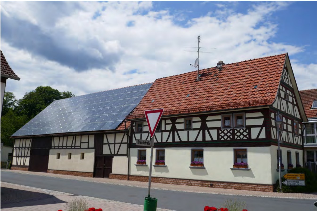
Ruhige Dachfläche durch gleichmäßige Anordnung der Module
