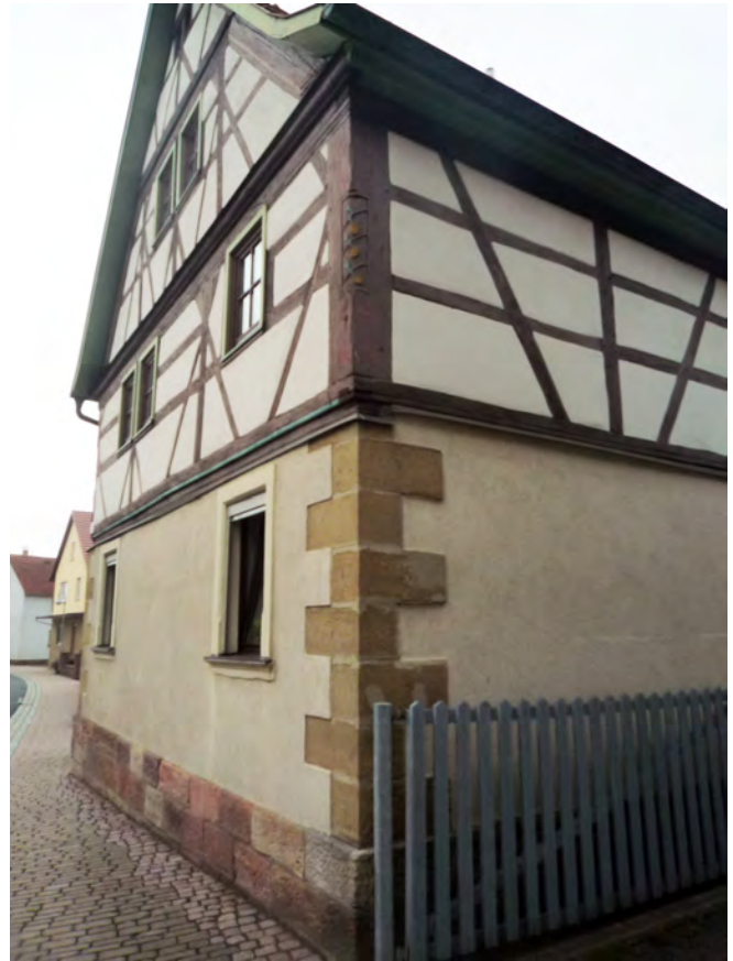
Ecklisene im Sockelbereich, Schmuckdetail im Fachwerk
