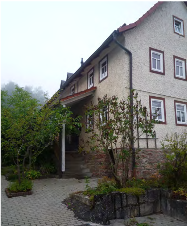
Eingangsüberdachung als unauffällige Pultdachkonstruktion
