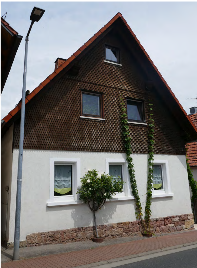
Giebel mit Holzverkleidung (Schindeln)
