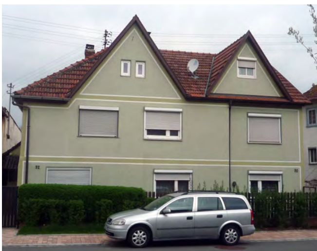
Negativbeispiel: unpassende Gauben und Zwerchgiebel verfremden das Gebäude
